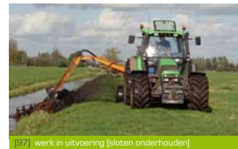
[97] werk in uitvoering (sloten onderhouden)
